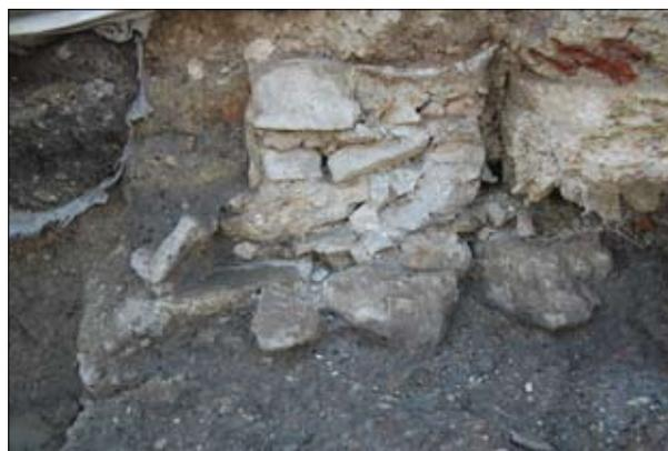
Fig. 9. Struttura muraria con fondazioni ed alzato in blocchi di calcare. Si possono anche osservare i livelli argillosi di sottofondazione.
