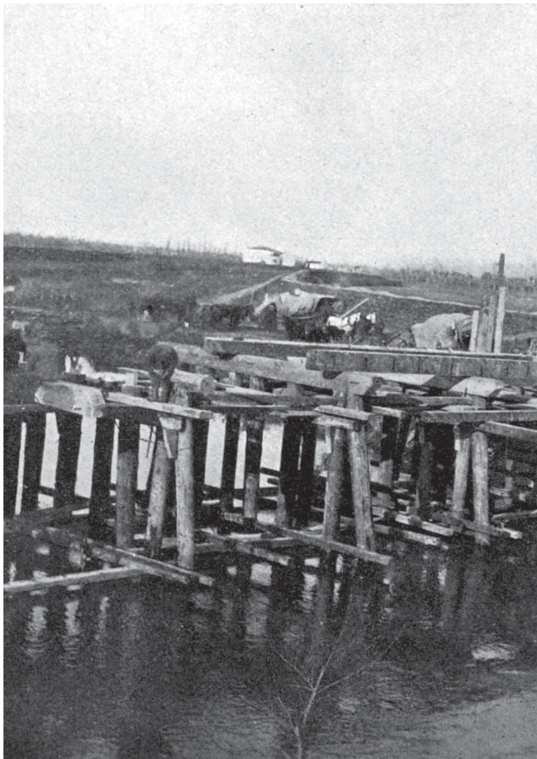
Battaglia di Vittorio Veneto. Costruzione di un ponte sul fiume Monticano presso Oderzo. SFEI.
