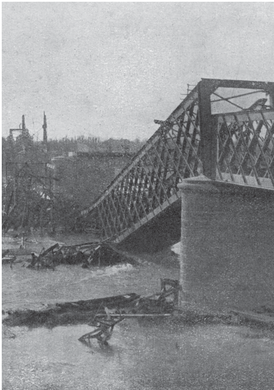
Battaglia di Vittorio Veneto. I primi lavori di riattamento a Ponte di Piave. SFEI
