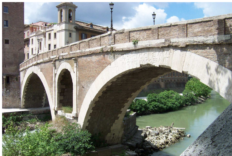
Fig. 17. Ponte Fabricio. Il ponte aveva in età antica una lunghezza totale di circa 80 mt, con due grandi arcate. La pila centrale ha un possente avambecco triangolare a monte, mentre a valle presenta un retrobecco semicircolare. Le arcate presentano archi di testata in travertino con archivolti a corona quasi semicircolare. La posa in opera dei cunei è sempre di testa e nell'intradosso si immorsano a dente con le volte di pietra sperone. La cornice di coronamento, ancora visibile in pochi segmenti, era modanata con gola rovescia sormontata da un listello.
