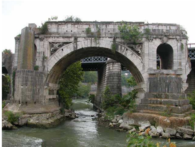
Fig. 16. Ponte Emilio. E' il secondo ponte costruito a Roma dopo quello Sublicio che si trovava immediatamente a valle, ma senz'altro il primo che ebbe una versione in pietra. Era lungo 135 mt e largo 8,83 mt; aveva 5 pile larghe 5,36 mt e lunghe circa 9 mt, con struttura interna in tufo e rivestimento esterno in pietra sperone mista a tufo dell'Aniene, in conci disposti secondo la tecnica dell'opus quadratum; le pile erano difese a monte da un avambecco triangolare e a valle da un retrobecco trapezoidale di travertino. Le arcate erano 6, a tutto sesto, ed avevano luci che andavano da mt 16,50 in quella centrale a mt 14,50 in quelle d'estremità. Le spalle erano forate da un'arcatella di scarico a tutto sesto relativamente ampia che consentiva sia il deflusso delle acque in caso di piena e serviva per agevolare il traffico. Ogni arcata mostrava archivolti in vista a corona semicircolare. Il piano d'imposta aveva in origine un'assise in travertino da cui uscivano con forte aggetto 5 mensole a sezione quadrata. Le arcatelle di scarico erano contornate da piastrini corinzi.
