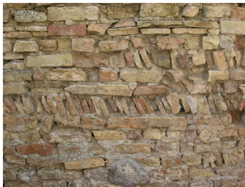
Fig.7. Esempi di muro romano realizzato con tecnica mista. Concordia Sagittaria, sotterranei della Basilica paleocristiana.
