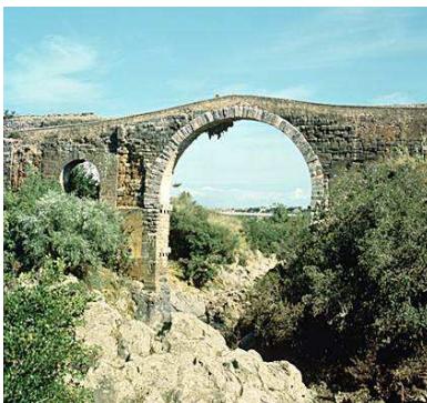
Fig. 13. Ponte della Badia a Vulci. Lungo complessivamente 83 mt, presenta una struttura asimmetrica in cui prevale l'arcata centrale, mentre le spalle laterali sono entrambe forate da arcatelle sussidiarie.
