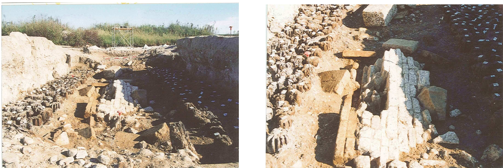
Figg. 20-21. Vedute generali dei resti del ponte romano. Al centro dell’alveo, il possente spezzone murario che costituisce la testimonianza del muro d’imposta nord-est del ponte.
