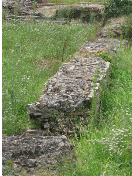
Fig.4. Esempio di muro romano con interno in opus caementicium . Aquileia, porto fluviale.
