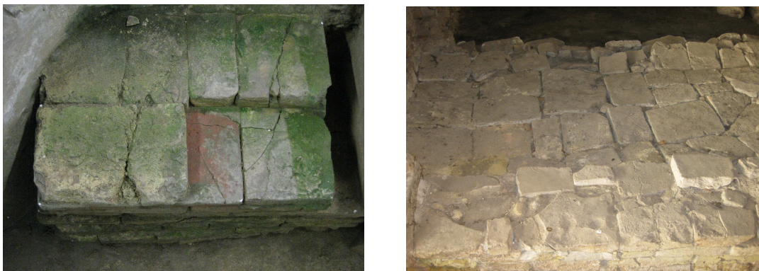
Fig. 5. Esempi di muro in opus latericium . Aquileia, sotterranei della Basilica e Concordia Sagittaria, antica Basilica paleocristiana.
