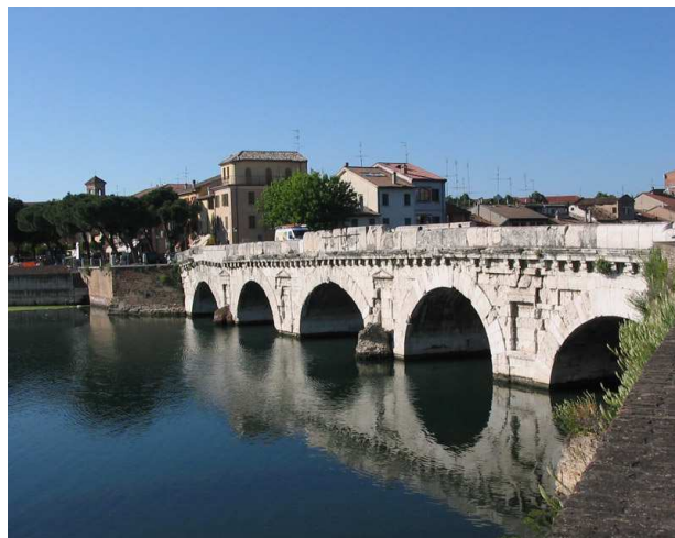
Fig. 20. Ponte di Tiberio a Rimini. Attualmente ancora in uso, questo manufatto è senz'altro uno dei più integri e famosi di tutto il mondo antico. Esso è stato prescelto dai trattatisti rinascimentali, soprattutto dal Palladio, quale modello insuperabile di ponte. Il ponte è tutto rivestito di pietra d'Istria, mentre il nucleo è probabilmente in calcestruzzo. E' lungo 74 mt, poggia su 4 pile con rostri, mentre le arcate hanno luci da mt 8,45 a mt 10,70 quella centrale. Il rivestimento è in opera quadrata con conci in pietra d'Istria lavorati a bugnato semirustico con listello lungo i piani di giunto. I muri di testata dei timpani presentano grandi nicchie a pseudoedicola il cui scopo, oltre che di alleggerimento, appare per lo più sacro. Tutte le edicole presentano la medesima struttura: la nicchie rettangolare è fiancheggiata da due piastrini senza base, con fusto piatto e liscio ornato da un capitello di tipo tuscanico. Sopra gli abachi poggia una trabeazione di tipo ionico con architrave. Il parapetto è formato da lastre disposte a parallelepipedo rettangolo. In corrispondenza dell'arcata centrale, il parapetto porta un'iscrizione: ..Augustus pontifex maxim...Caesar divi Augusti.... Dalle iscrizioni si conosce che il ponte fu iniziato sotto l'imperatore Augusto, ma fu portato a termine dal suo successore Tiberio nel 21 d.C.
