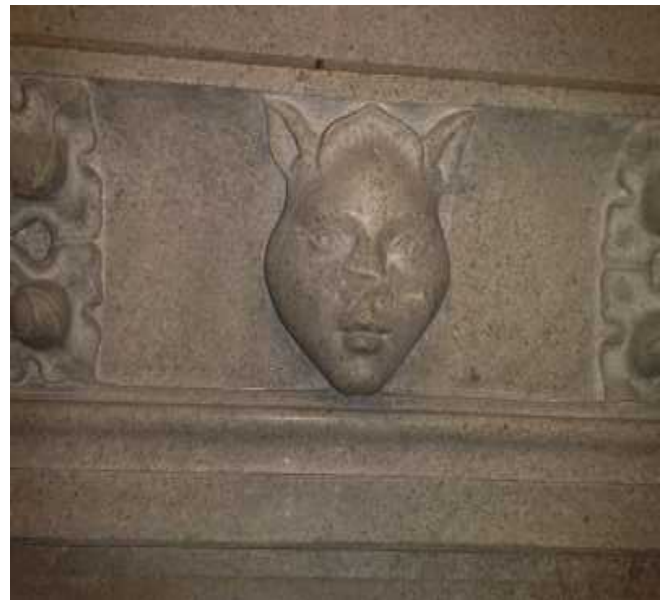
143. particolare del camino gotico
