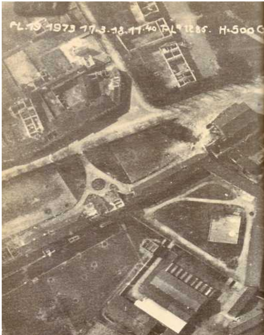
121 L'Agenzia di San Polo danneggiata dalla guerra, foto aerea, 1918.
