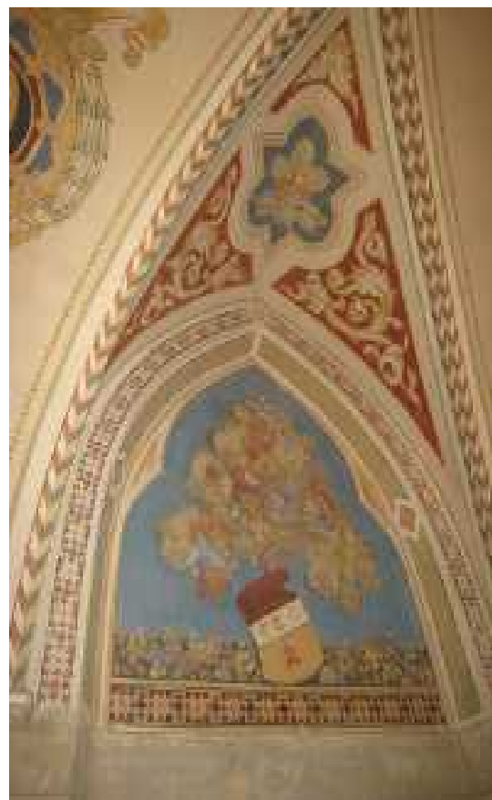
127 copertura a volta affrescata, particolare.
