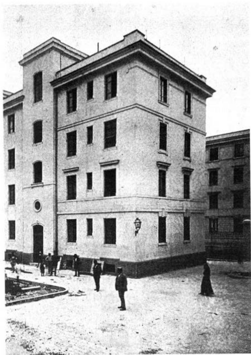
Fig. 26 - G.B. MILANI, Edificio al Testaccio.
