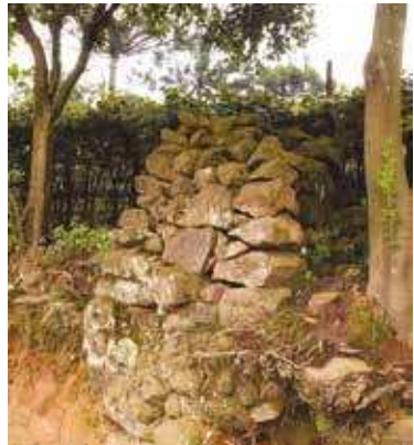
Foto 19. Si nota una pila di rocce dalle quali sporge una pietra su cui è ancorato un tirante ed è evidente l'erosione progressiva del suolo causata dall'ampliamento della strada.
