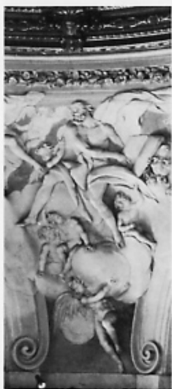
Particolare degli stucchi che decorano la volta della chiesetta.
