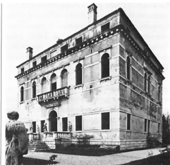
Ancora una veduta di villa Correr gravata dalla pesante sopraelevazione del granaio.
