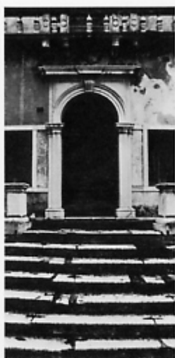
Particolare del portale d'ingresso al salone del piano terra.
