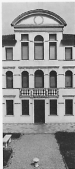
Particolare della parte centrale della villa. Si notino le proporzioni del salone centrale a doppia altezza proposte in facciata con la trifora e la soprastante serliana.
