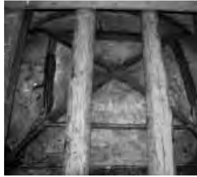
9. Estradosso della volta durante la ricostruzione della struttura lignea.
