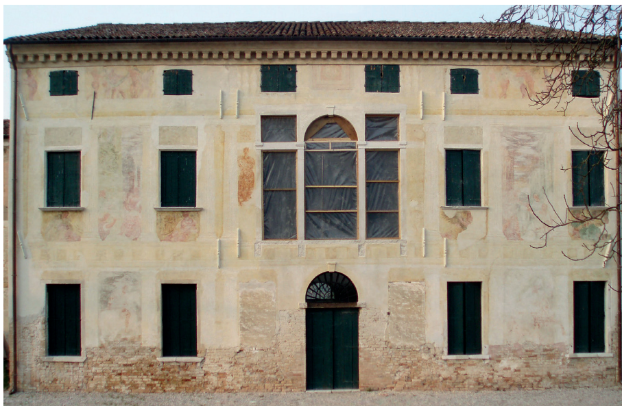
9. Facciata sud dopo il restauro.
