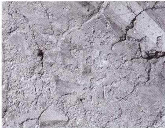
Fig. 19. Ca' Salvini, esfoliazione e polverizzazione del film pittorico.
