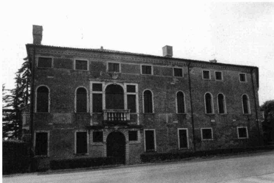
Veduta del fronte nord, prospiciente la strada (L.S. 1998)
