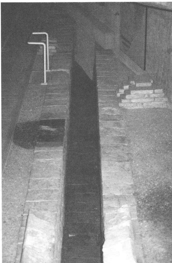
Fig. 15. Il grande collettore fognario che originariamente correva al di sotto del lastricato della strada adiacente il lato sudoccidentale dell'isolato forense (n. 48).
