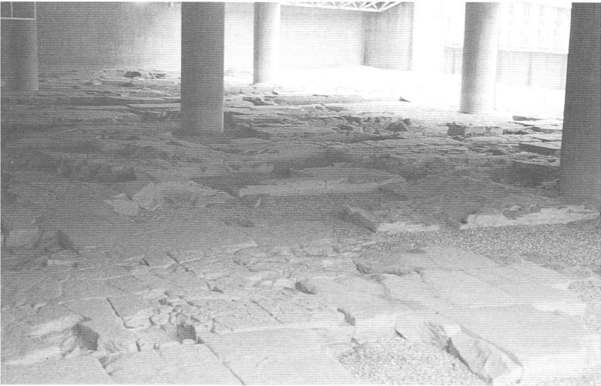
Fig. 20. Veduta della piazza forense a restauro ultimato.
