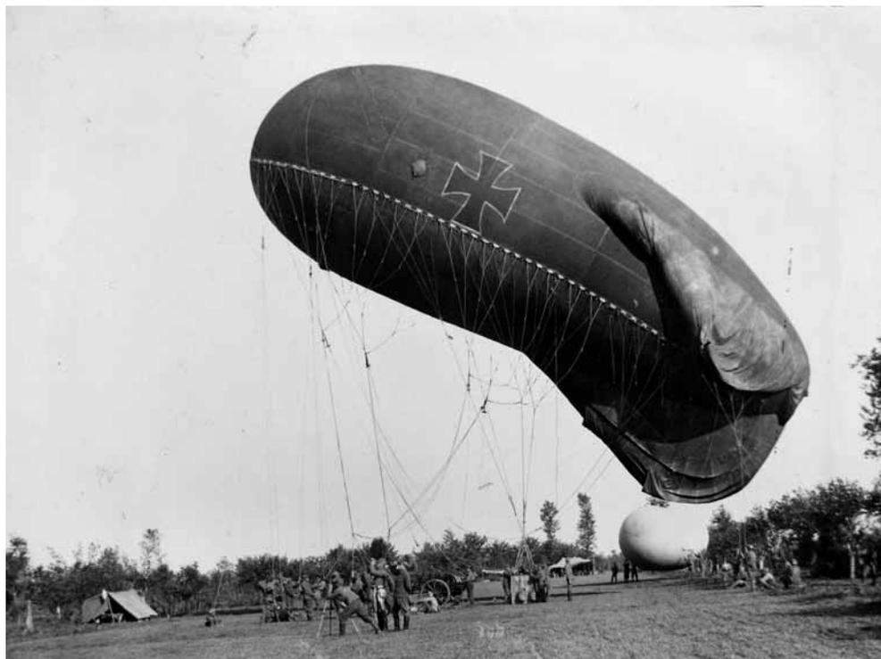
*Il «Draken» di Rustignè, che forse sostituì quello abbattuto da Ancillotto. Si noti in secondo piano un piccolo pallone che serviva per la manutenzione dell'aerostato. Foto collezione privata.*
