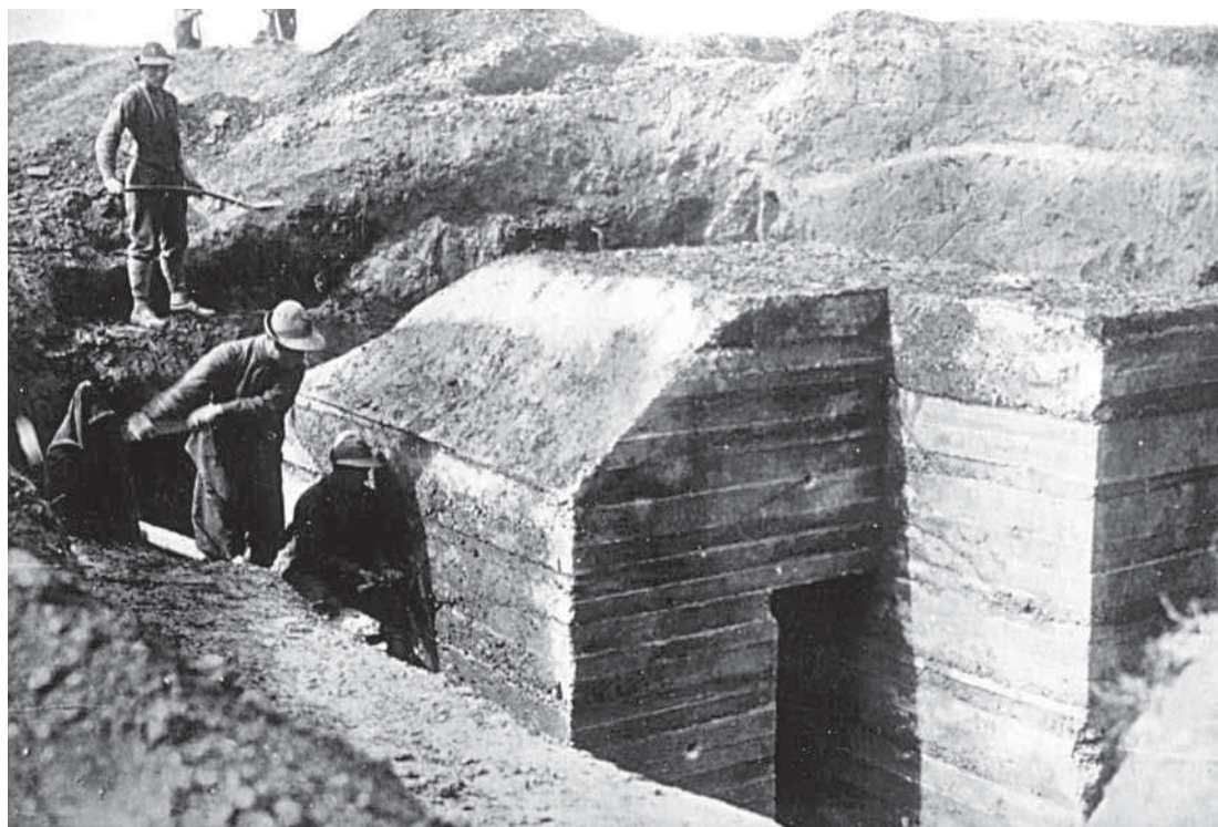
Demolizione di un rifugio in cemento armato
