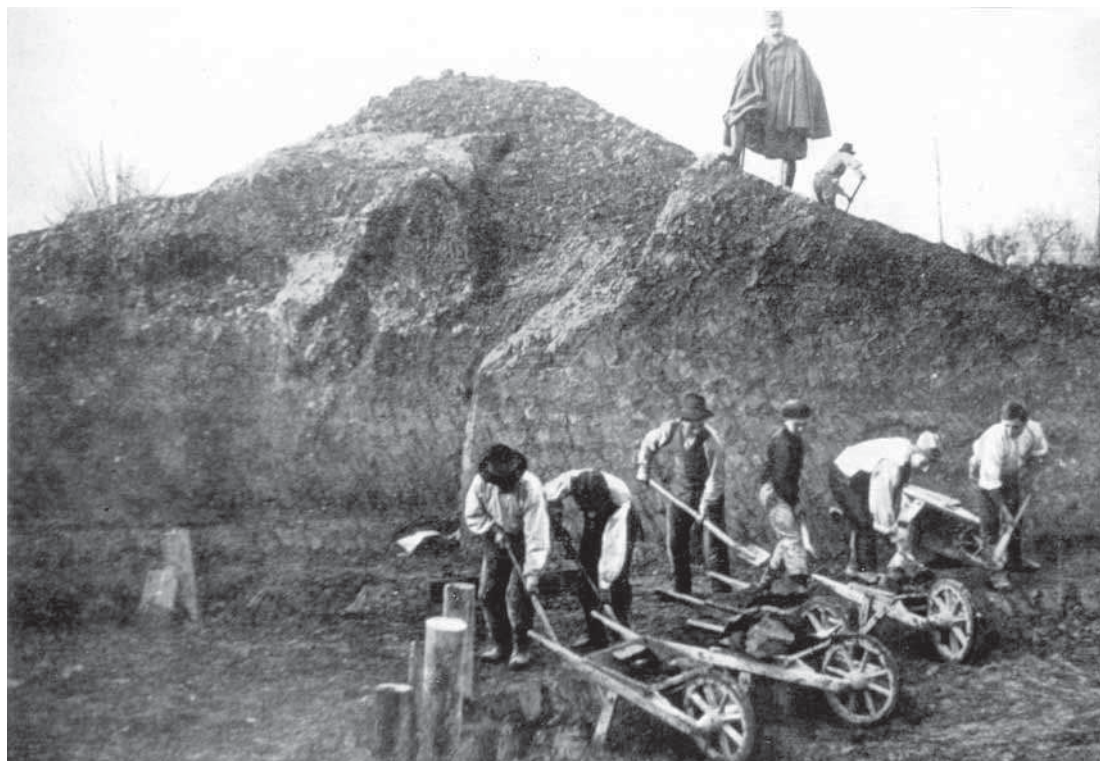
Lavoratori civili impegnati nell'opera di ricostruzione degli argini del Piave
