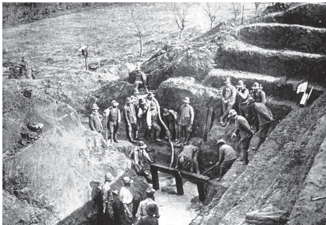
Si rimuovono corpi estranei dalla massa arginale
