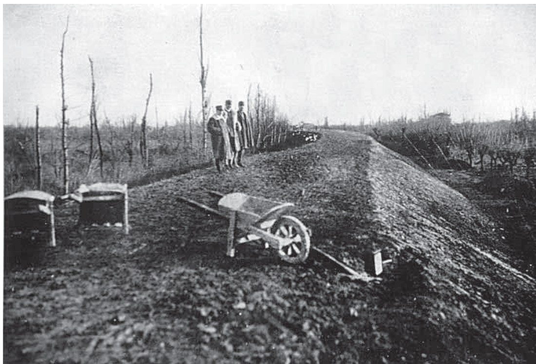
Ufficiali italiani compiono una ricognizione sugli argini del Piave per verificare lo stato di avanzamento dei lavori
