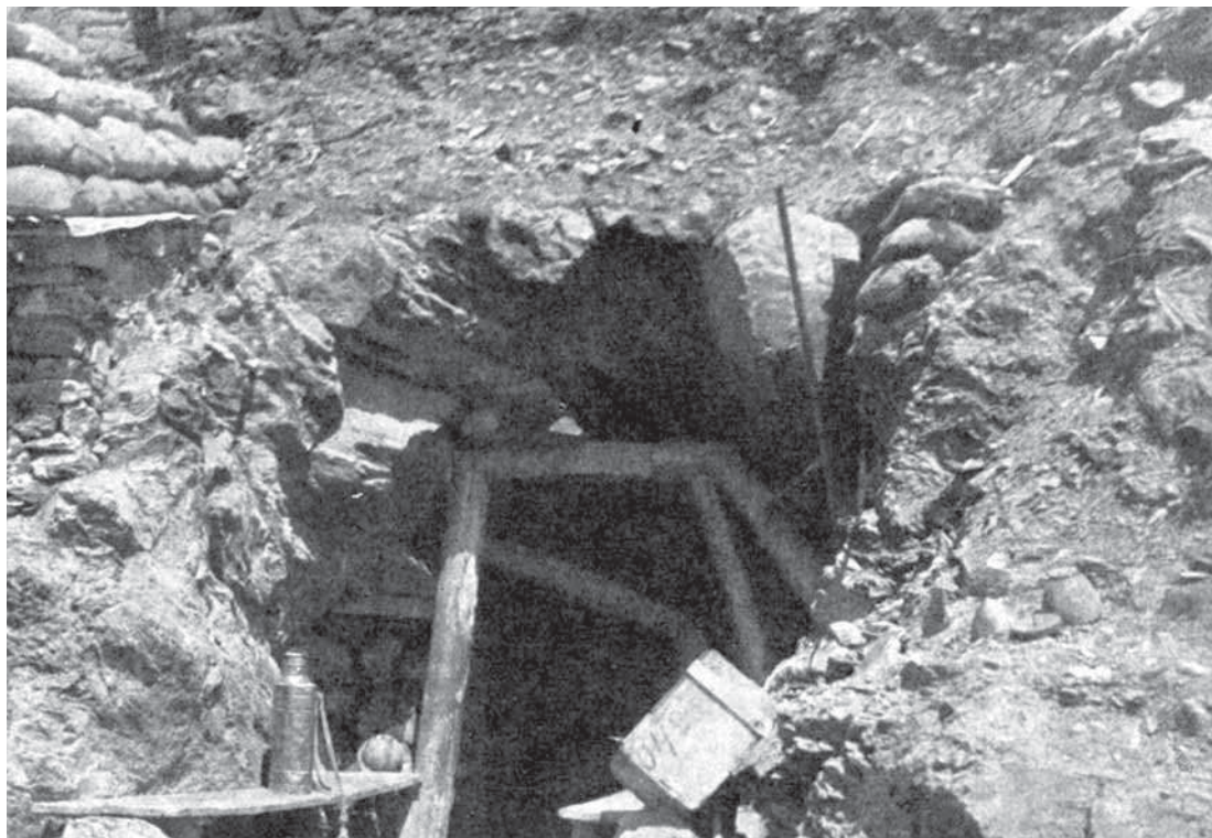
L'imbocco di un ricovero scavato nella montagna.
