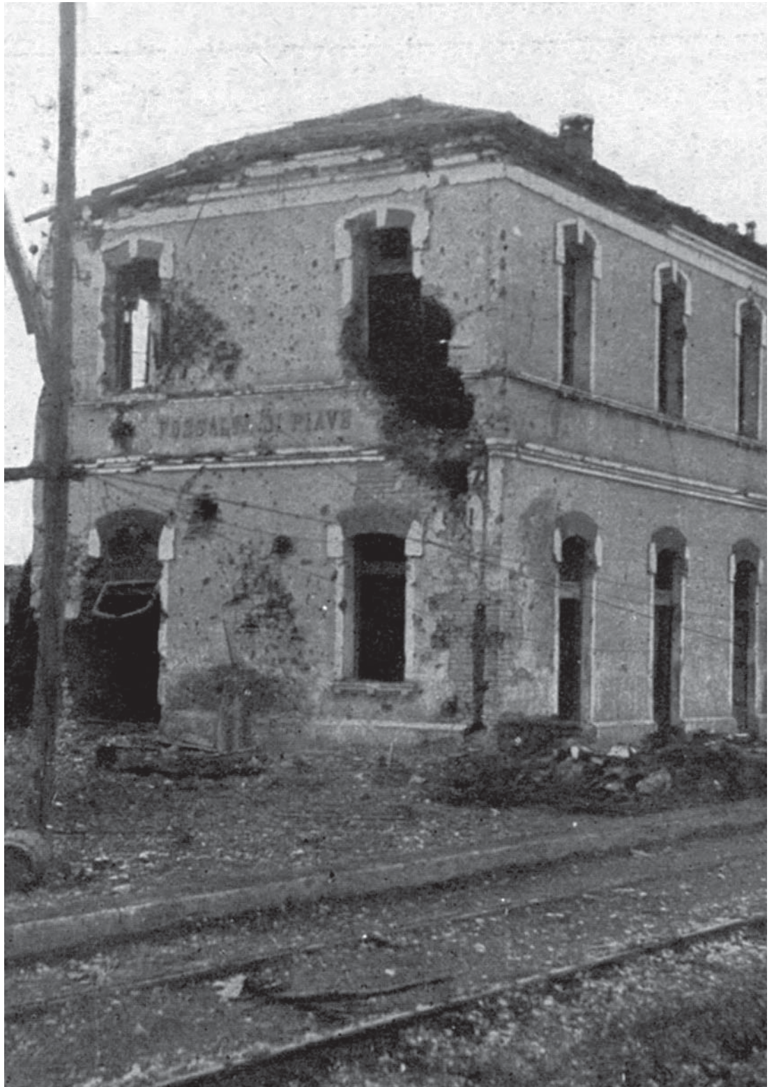
Giugno 1918. Le rovine della stazione di Fossalta di Piave Servizi Fotografici dell'Esercito Italiano
