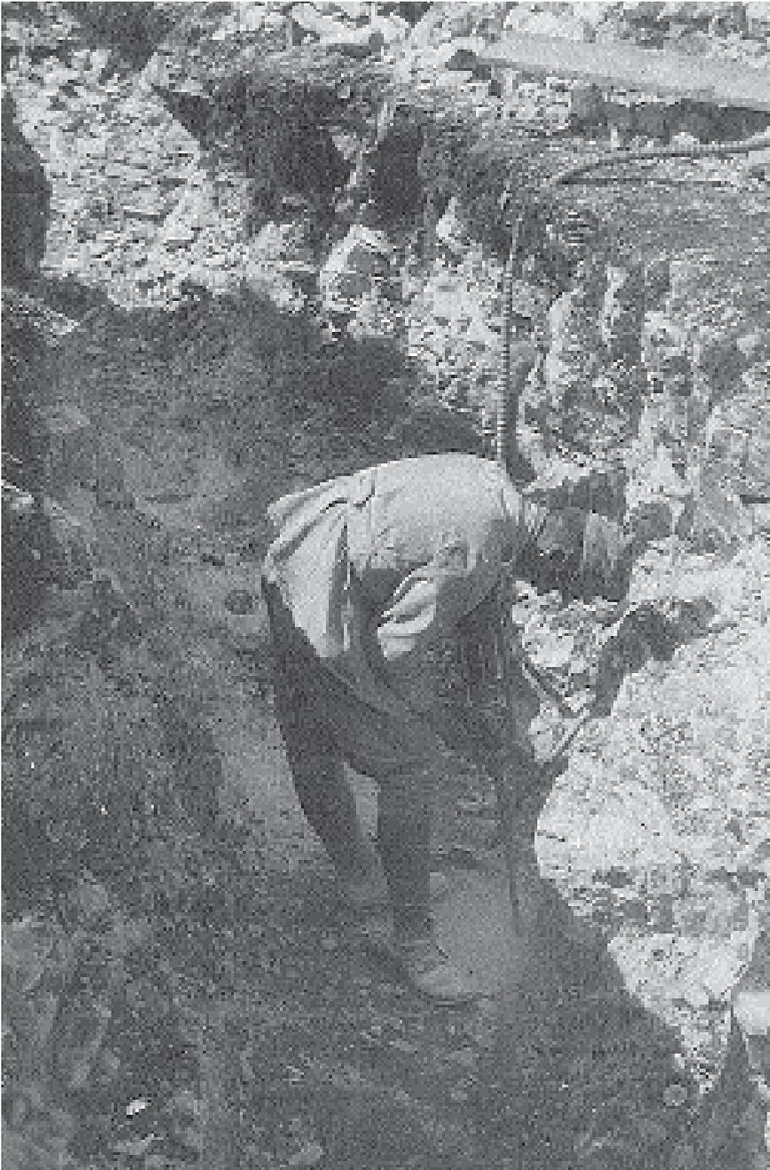
*Scavo di una trincea nella roccia carsica con l'ausilio del martello pneumatico
