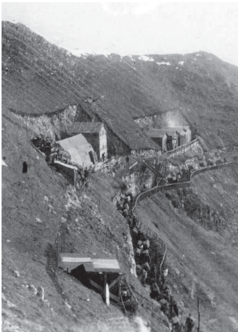
Strada di arroccamento e baracche sull'Archeson. Si notino i veri e propri «tagli» inflitti alla montagna al fine di ricavare gli spazi indispensabili alla costruzione della costruzione dei ripari. Archivio Istresco - Fondo Cipriani
