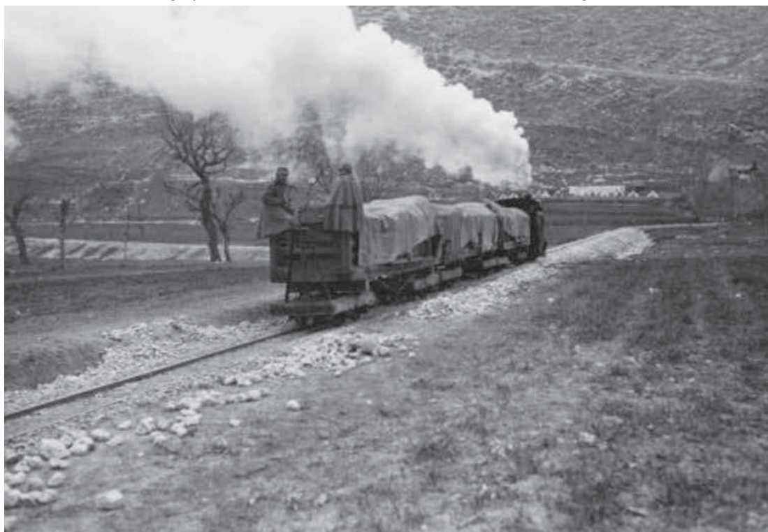
Binari a scartamento ridotto ritpo «Decauville» e relativa trattrice. Servizi Fotografici dell'Esercito Italiano. Museo Centrale del Risorgimento Roma.
