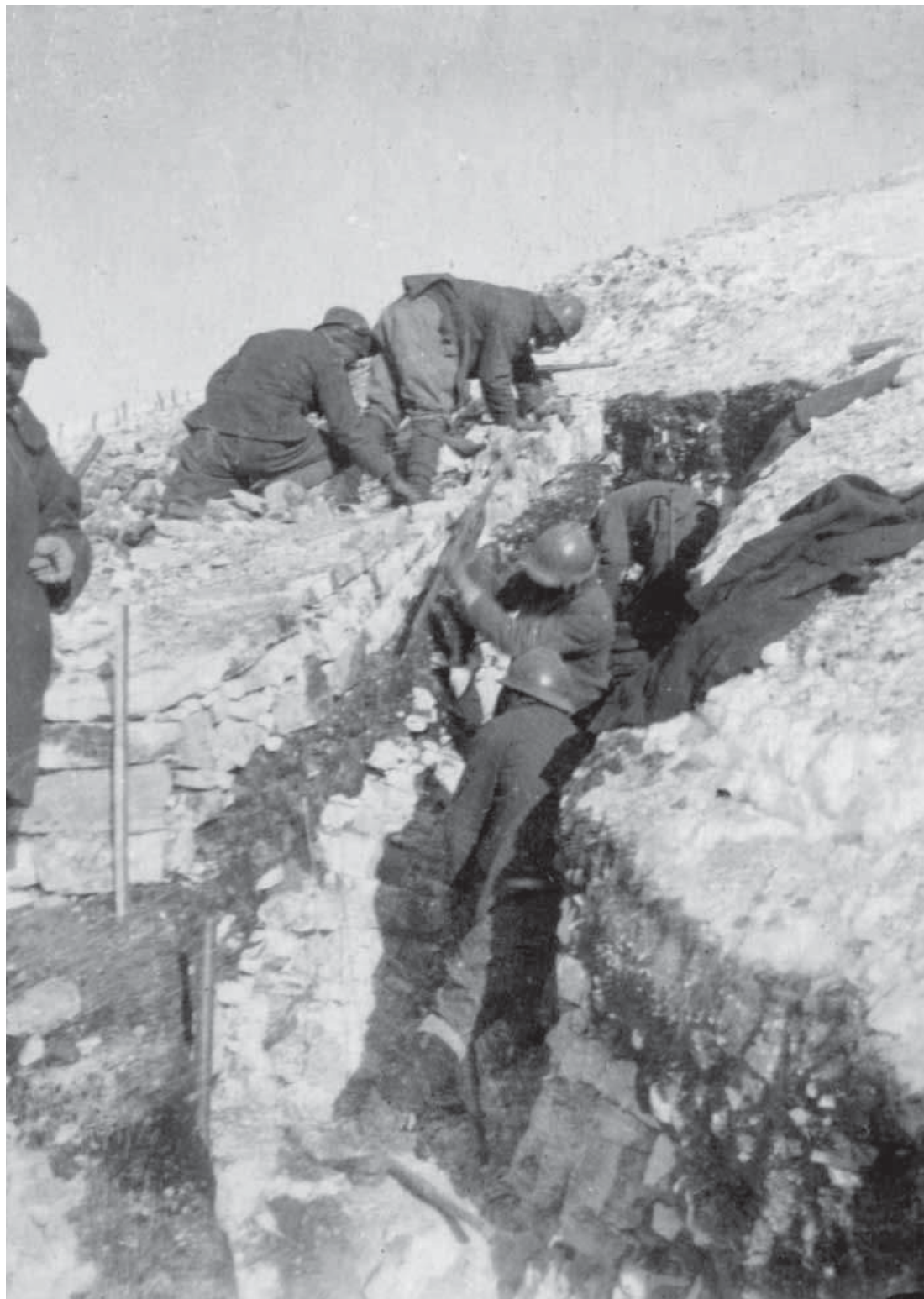
Massiccio del Grappa. 4 gennaio 1918. Sistemazione del «ciglio di fuoco» di una trincea Archivio Istresco - Fondo Cipriani
