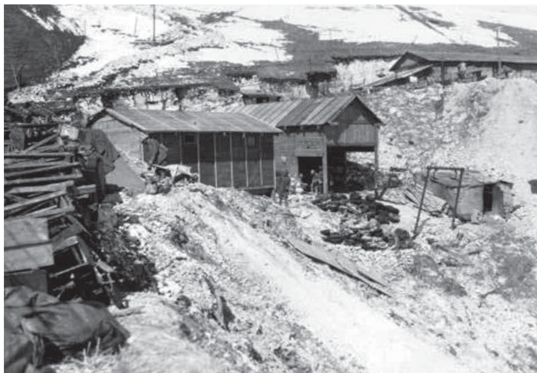
Massiccio del Grappa - La stazione di arrivo di una teleferica. Servizi Fotografici dell'Esercito Italiano. Museo Centrale del Risorgimento Roma.
