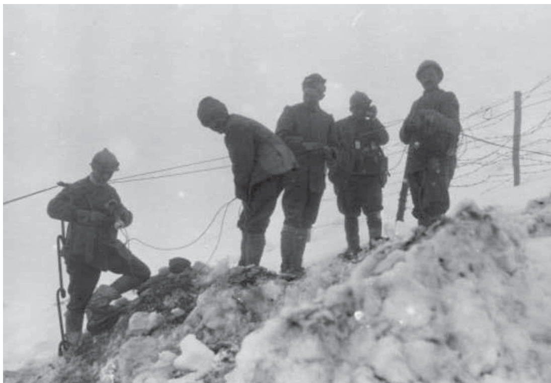
Genieri posano i cavi per le comunicazioni telefoniche. Servizi Fotografici dell'Esercito Italiano. Museo Centrale del Risorgimento Roma.
