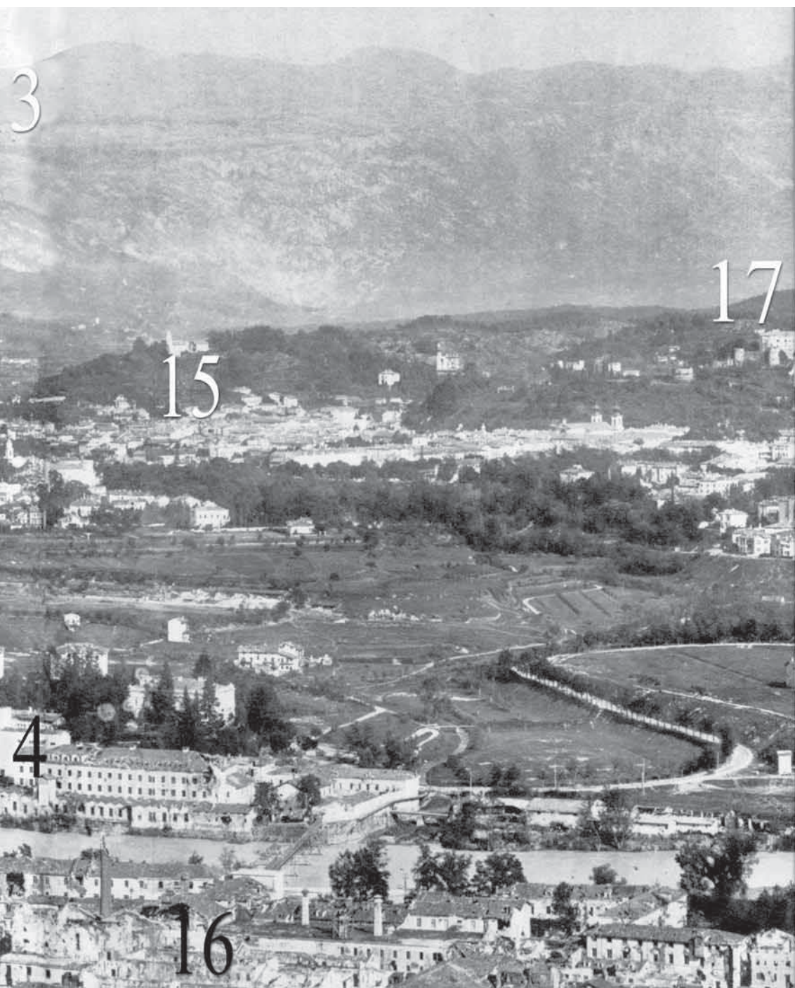
La piana di Gorizia vista dal Podgora. 10) la stazione, 11) il cimitero, 12) il monte San Daniele, 13) Ternova, 14) Borgo Strazig (oggi Straccis), con le fabbriche costruite dai Ritter Rittmeyer nella prima metà del XIX secolo, 15) Castagnevizza, 16) Podgora, con la passerella che collegava la cartiera alle frabbriche di Borgo Strazig, 17) il castello di Gorizia. Foto SFEI, Servizi Fotografici dell'Esercito Italiano.
