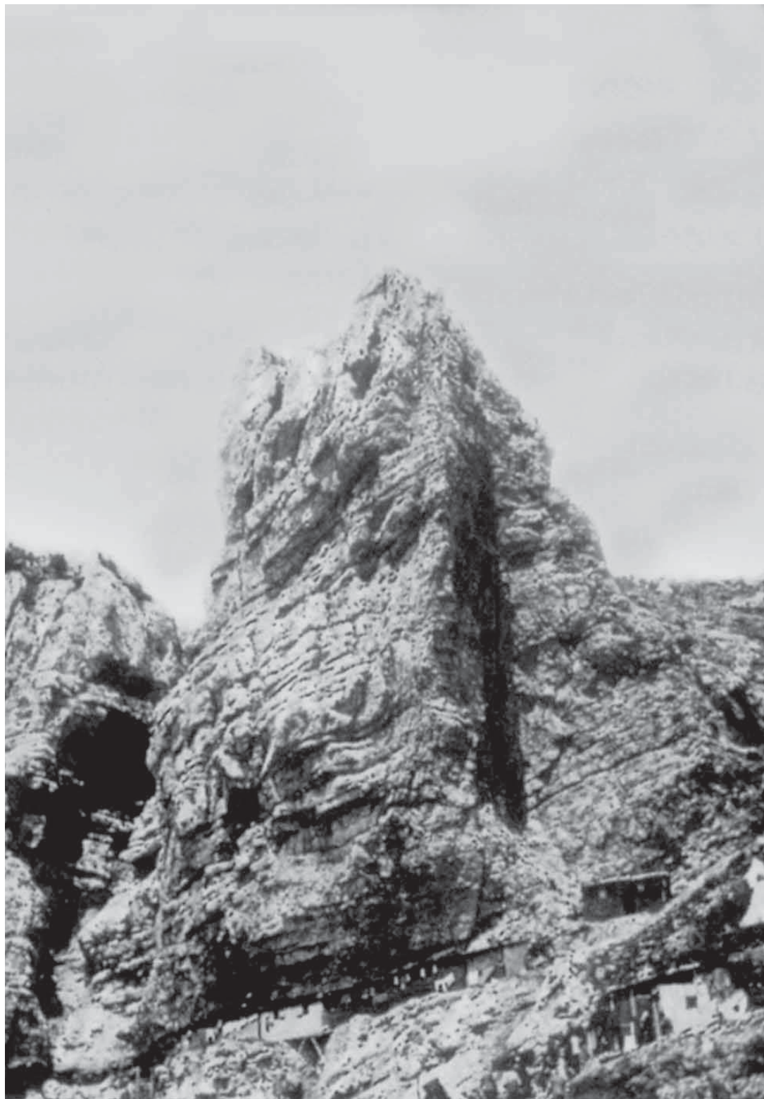
I Rocconi della Lora. Si notino i baraccamenti in basso: un crollo li avrebbe travolti provocando la morte del colonnello Testafochi.
