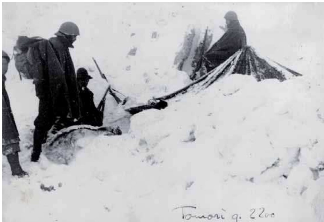
Fronte Greco- Albanese, settore del Monte Tomori (Tomorr Var), fine dicembre 1940. Alpini del Btg. «Feltre» - 7° Rgt. – Div. «Pusteria» in ricoveri con fondo di terra, pareti di neve e tetto realizzato con teli di tenda a quota 2200. Le condizioni di vita sono estreme. Archivio Emilio Pisani - Padova.
