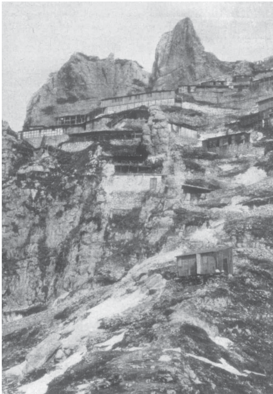
Settore del Pasubio. Baraccamenti del comando sottosettore Cosmagnon (Roccia Lora).
