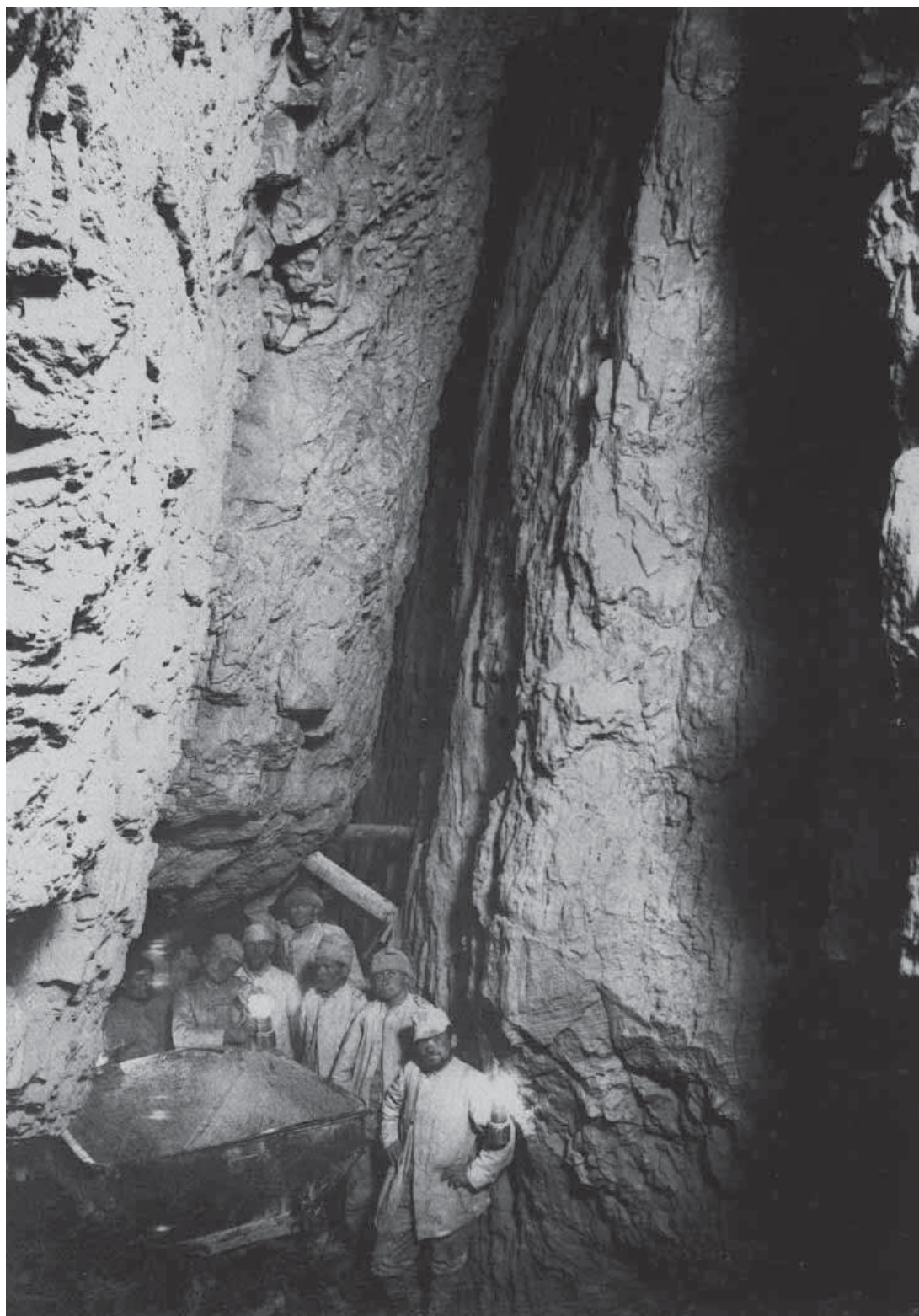
Gli alpini all'interno della galleria in una fenditura naturale incontrata durante gli scavi. SFEI.
