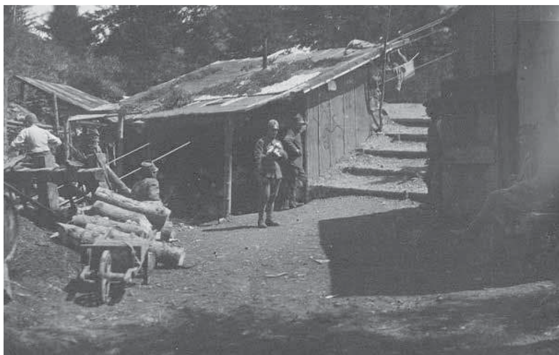
Lavori per la costruzione di barracche. SFEI.
