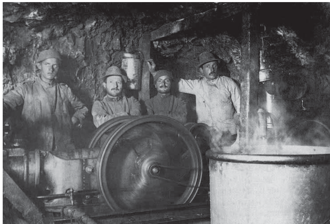
La camera del compressore «Ingersoll». SFEI.
