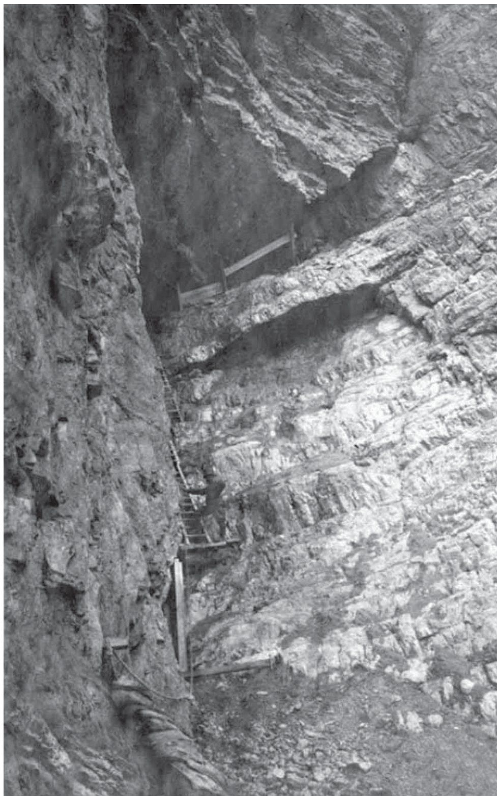
«Castelletto». Particolare del sistema di scale di accesso alla galleria. SFEI.
