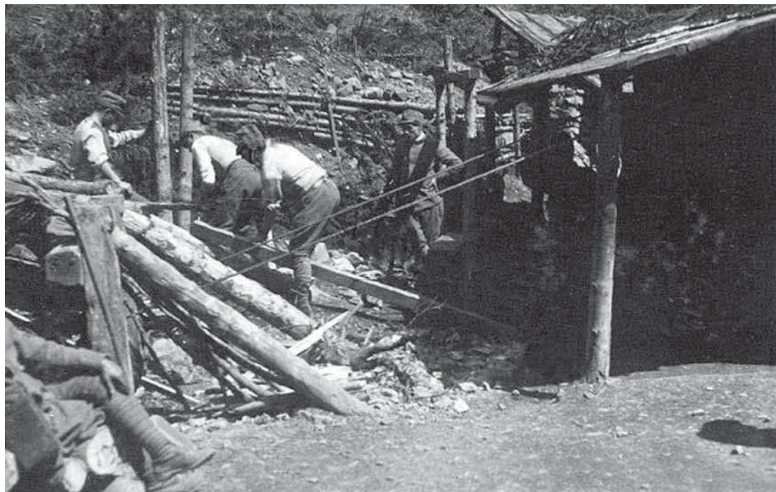
Lavori per la costruzione di baracche. SFEI.
